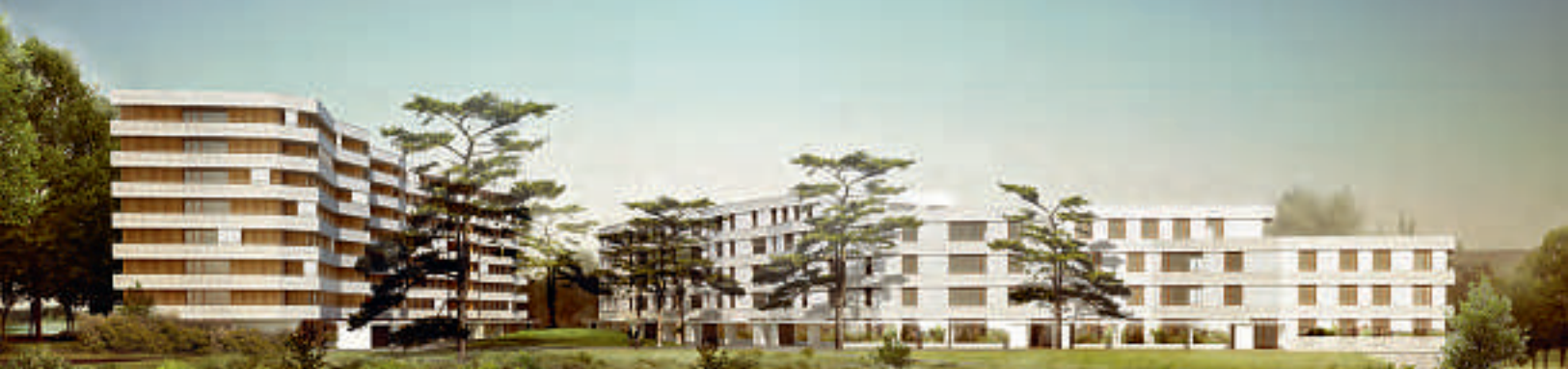
Neubau Baufeld B, Zellweger Areal Uster. Bauherr: Firmenpark Uster AG. Architekt: Gigon / Guyer Architekten Zürich. Kostenplanung, Baumanagement: b+p baurealisations ag, Zürich.
